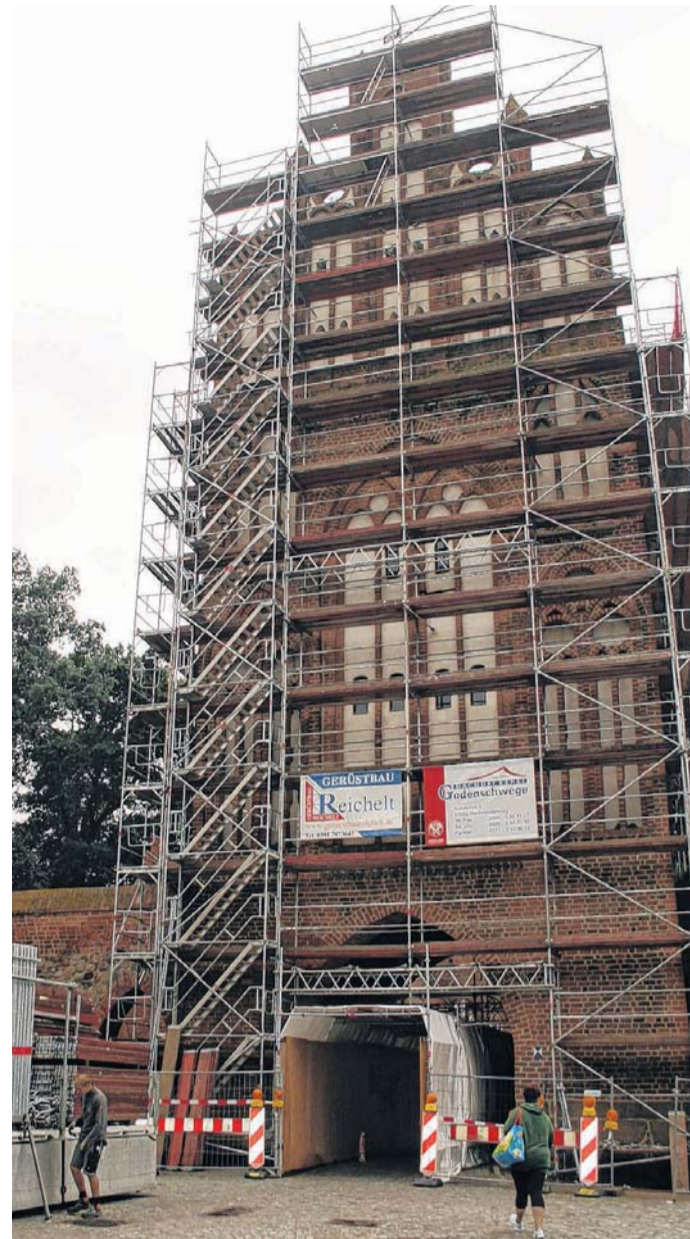
Das höchste der Neubrandenburger Stadttore verschwindet für einige Monate hinter einem Baugerüst. FOTOS (4): SUSANNE SCHULZ
